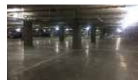
주차장 바닥 (무근콘크리트)
