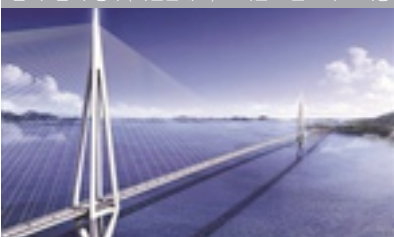
압해~암태1공구(새천년대교) - 저탄소 콘크리트 적용
