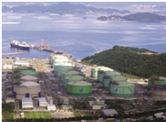
통영 LNG 터미널
